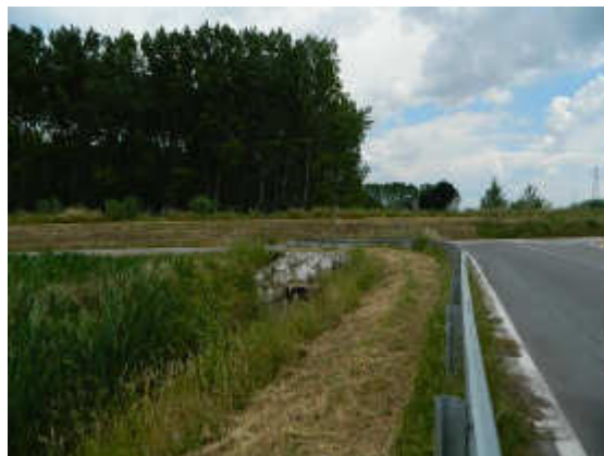
L'incrocio tra Via Avvocato Del Magro e Via Bernardini. Dalla foto si osserva la Fossa Nera e il bypass sotto il canale Fossa Nuova
