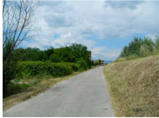
L'argine del canale di acque alte Fossa Nuova lungo Via Bernardini
