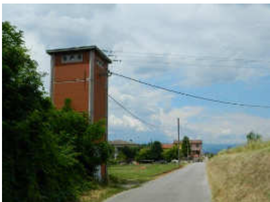
La cabina elettrica posta ungo Via Bernardini. Non vi sono cavi in arrivo da sud e da ovest dove si estende il terreno oggetto di trasformazione
