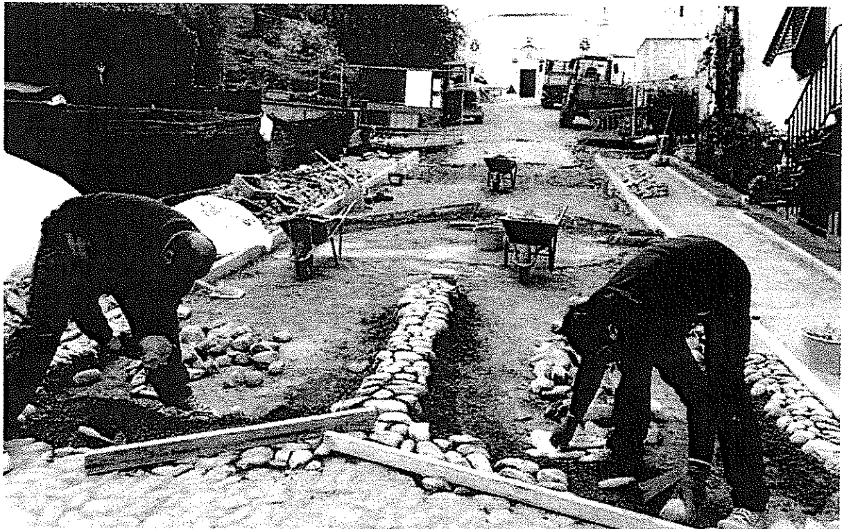
↑ Le pillole lapidee smontate sono state accatastate e conservate in prossimità delle aree di lavorazione in modo da garantirne il re-impiego locale con configurazione molto vicina allo stato originario;
