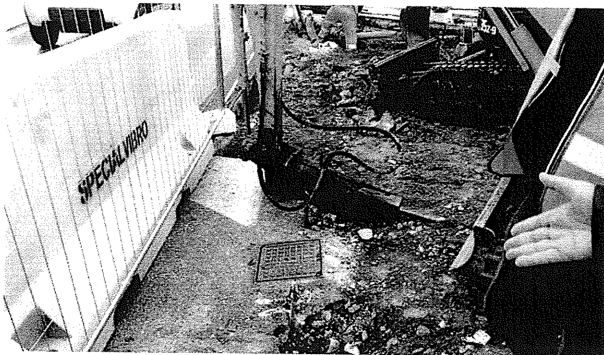
↑ I lavori di smontaggio e asportazione del manto in acciottolato eseguiti a mano e con l'ausilio localizzato di mezzi meccanici;
