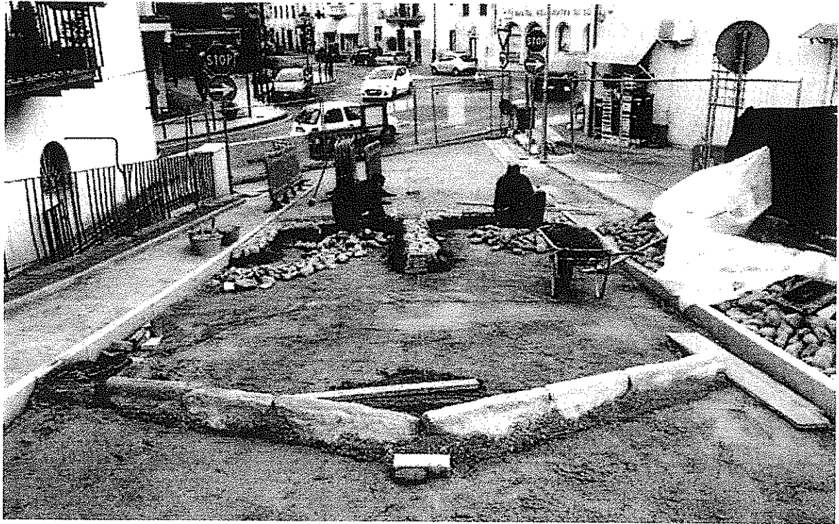
↑ Operazioni di posa dell'acciottolato lapideo eseguito manualmente, mediante re-impiego totale del materiale precedentemente smontato, previo pulitura;
