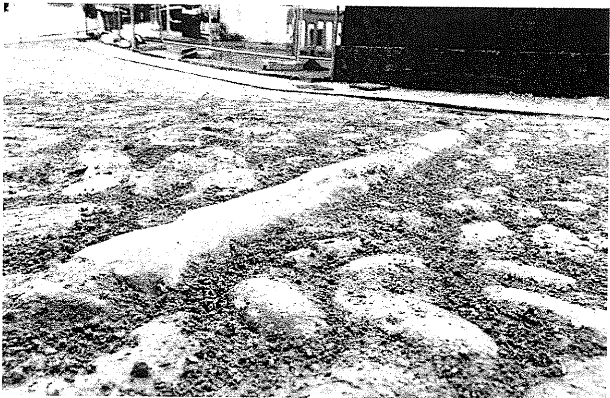
↑ Particolare ravvicinato dell'acciottolato lapideo dopo la nuova posa;
