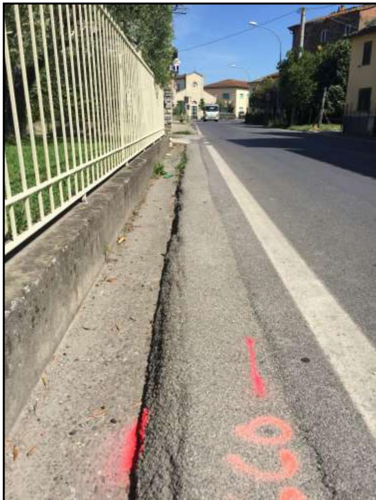
Foto 2 – Riempimento con asfalto al fine di creare una banchina adeguata
