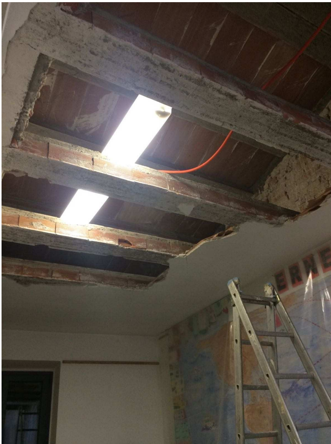
Demolizione parziale delle tavelle pericolanti nel quarto campo della copertura dell'atrio
