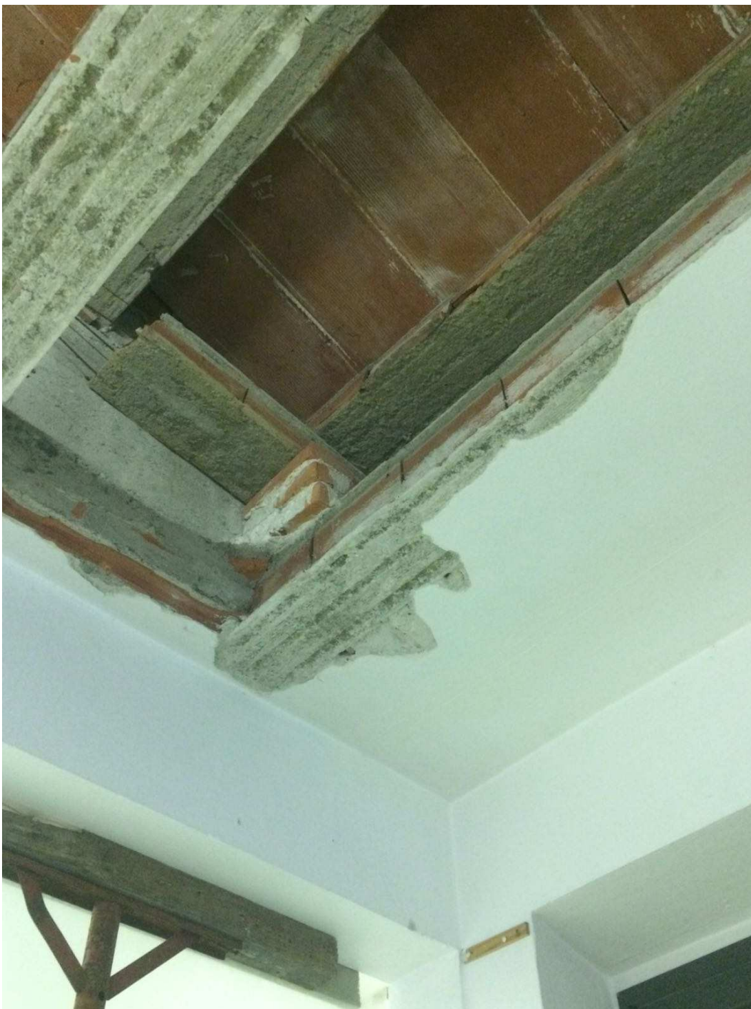
Vista locale di uno spigolo della copertura dell'atrio dopo la demolizione delle tavelle
