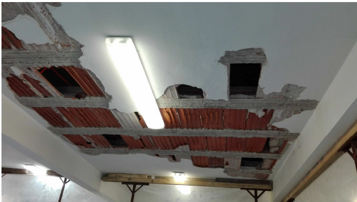
Rimozione delle porzioni pericolanti delle tavelle nel terzo campo di copertura dell'atrio
