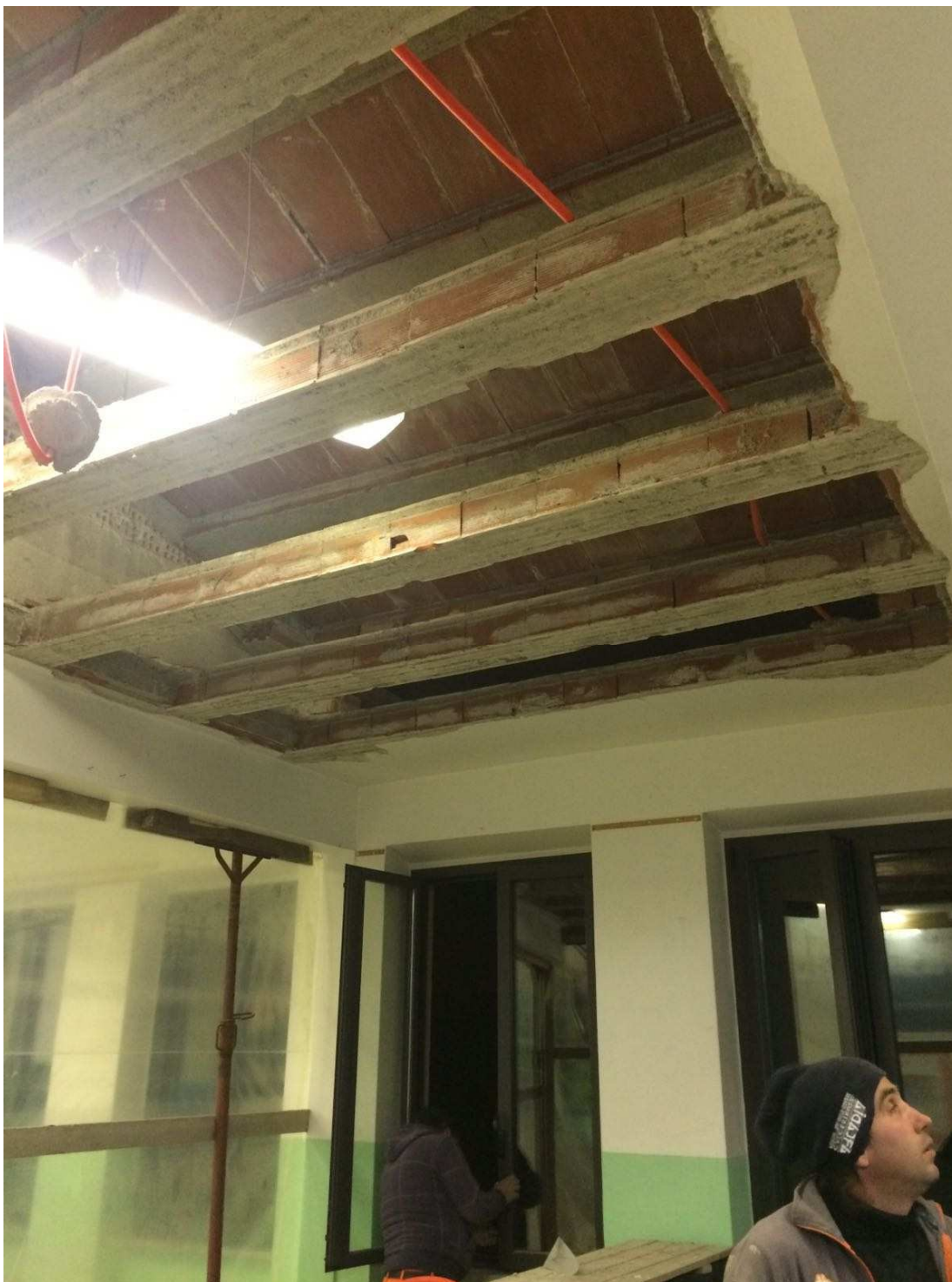
Demolizione totale delle tavole pericolanti nel terzo campo della copertura dell'atrio
