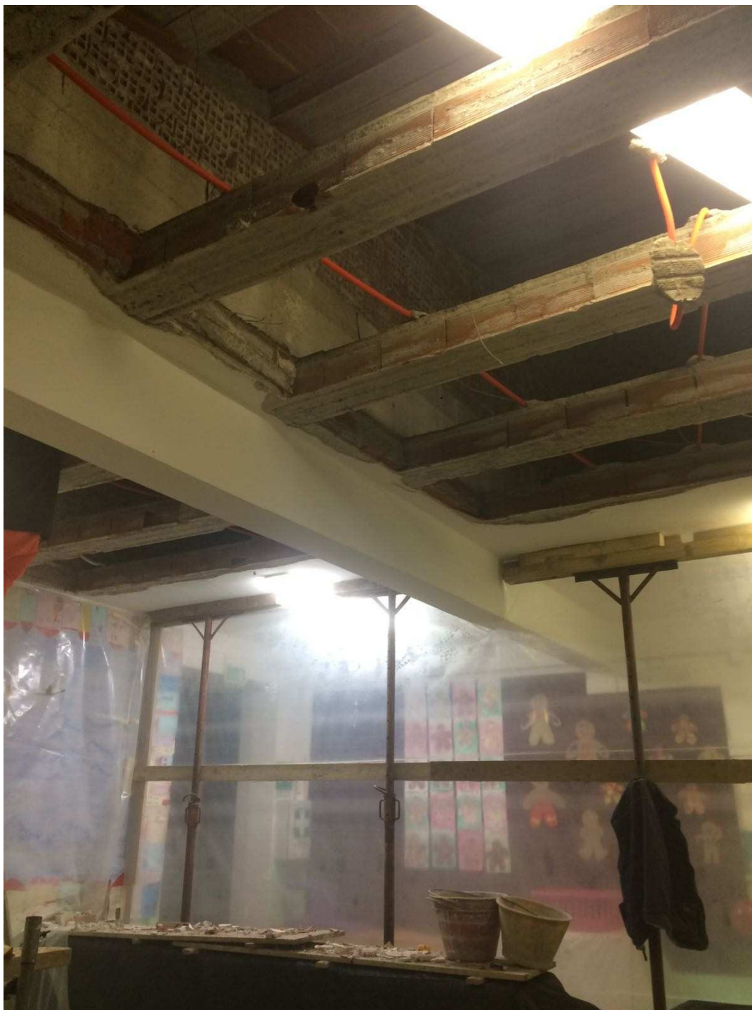
Demolizione totale delle tavelle pericolanti nel quarto campo della copertura dell'atrio
