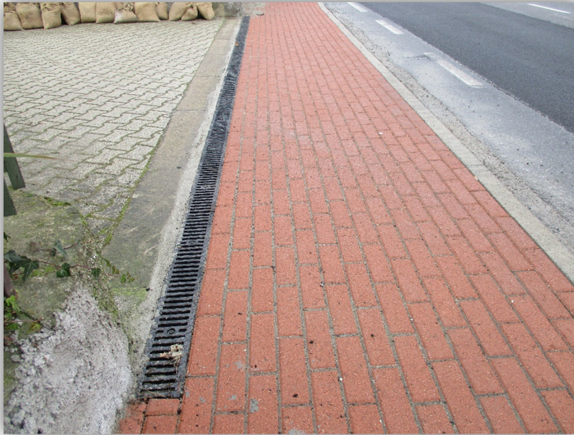
Gliglie per raccolta acque in corrispondenza di passo carrabile privato
