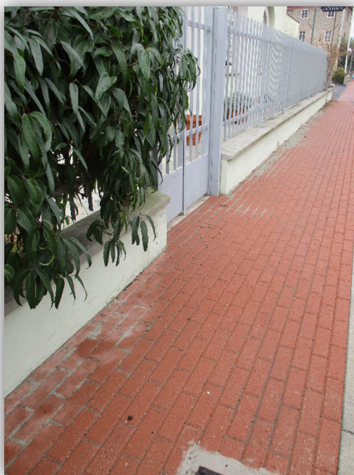
Tratto di marciapiede esistente in direzione Porcari
